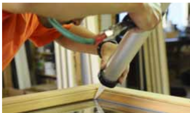
Iniezione semiautomatica del sigillante silconico tramite pistola ad aria compressa
