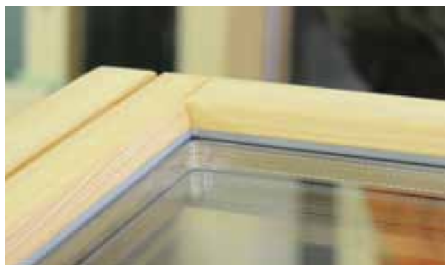
Il lavoro finito: il sigillante silconico iniettato nella giusta quantità e con la corretta inclinazione
