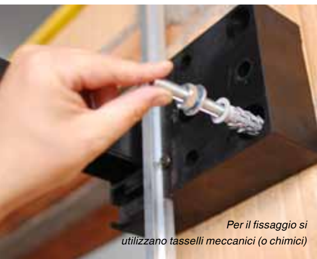
I blocchi portacardine fungono da dime di sé stessi
