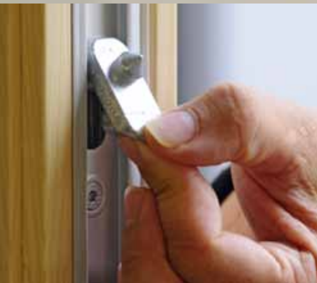
Dove forare? Il punto esatto lo indica la dima, che non ha bisogno di essere inserita a martellate ma solo appoggiata
