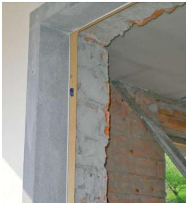
*Il Controtelaio Clima montato da Faliselli su spalletta prefinita*
