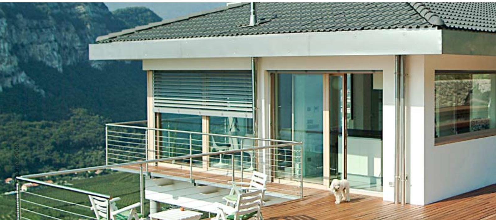
quella con cappotto esterno, dove la resa estetica e la funzionalità del prodotto forniscono i vantaggi maggiori. Particolare attenzione, comunque, va posta nel mantenere la planarità della lama in PVC in fase di posa del paramento esterno del muro.
