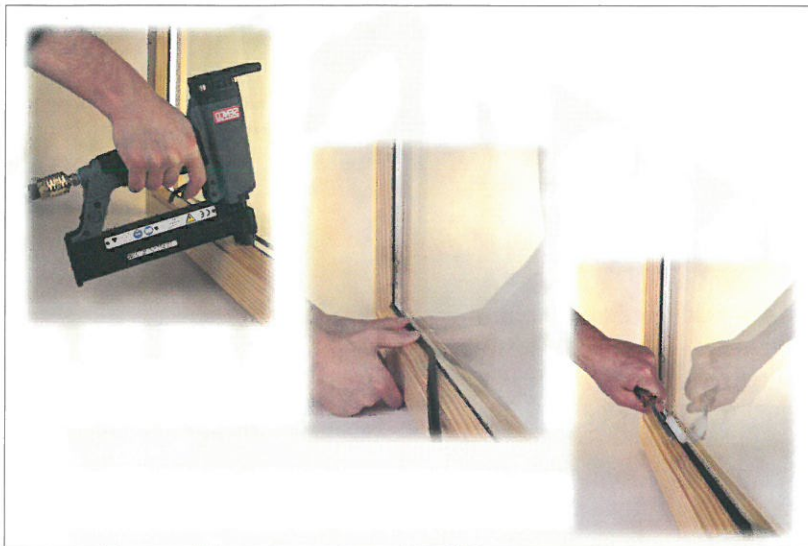
Sigillare il vetro a regola d'arte con guarnizione SV1 ed inchiodatrice SLP 20
