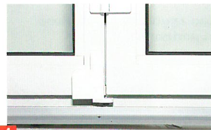
Foto 4: carrello di scorrimento e binario inferiore.
