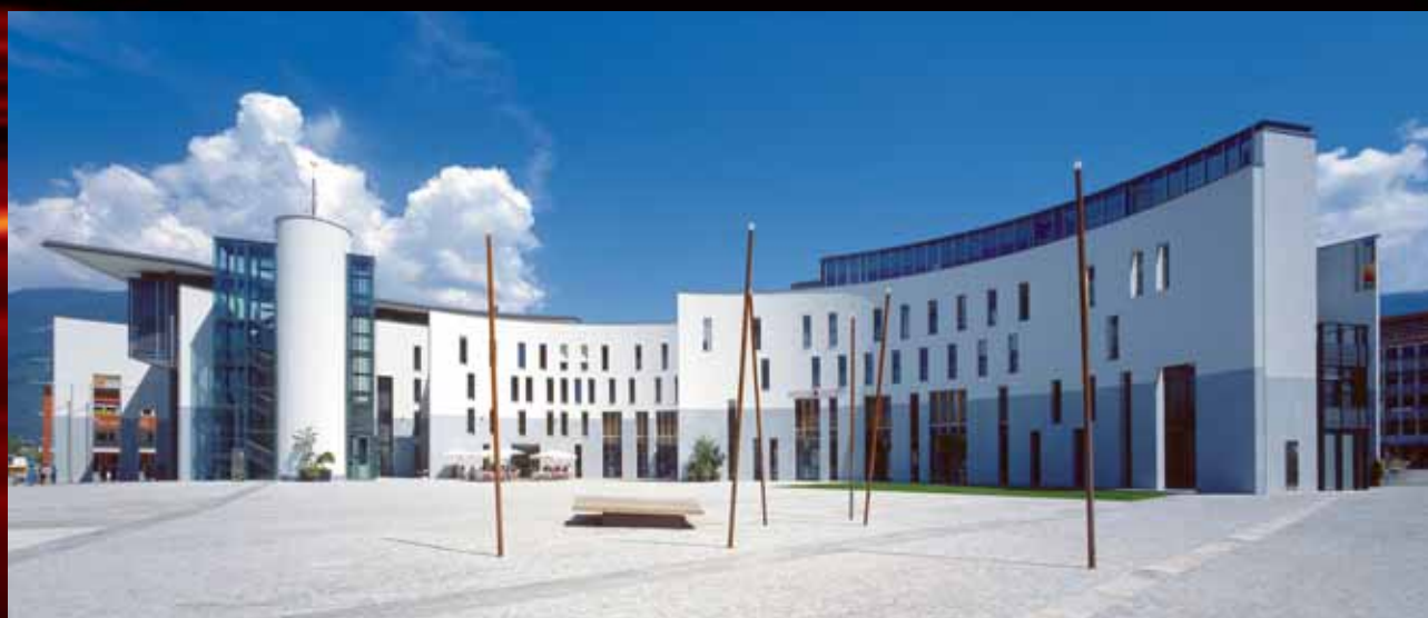
L'edificio del Comune di Brunico, CasaClima B
