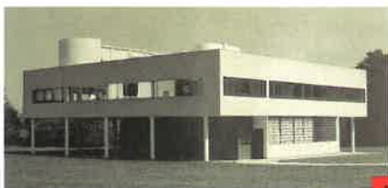
Fig. 7: Villa Savoye a Poissy di Le Corbusier; tratto da "Finestre alla ribalta".
